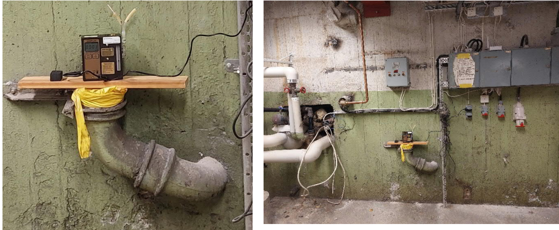
Figur 10. Pumpad provtagning av inomhusluft i det f.d. pannrummet på källarplan i Hus 315.
