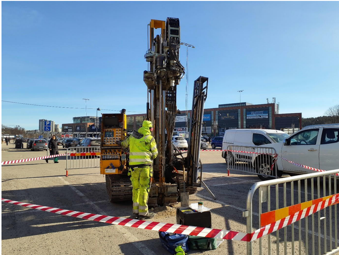
Figur 4. Jordprovtagning med borrhandsvagn, mars 2022. Bilden visar punkt 22W103 och är tagen på parkeringen söder om Hus 326.
