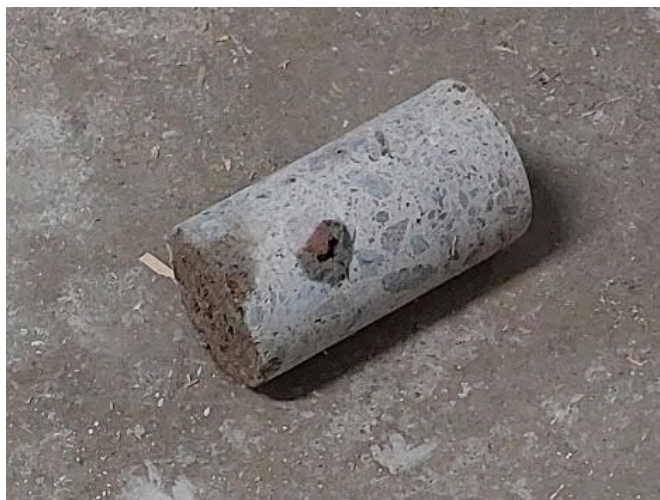
Figur 6. Betongkärna uttagen i punkt 22W315_PL9.
